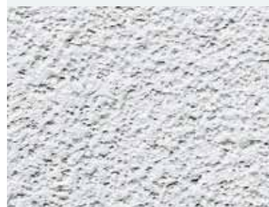
Maçonnerie crépie
