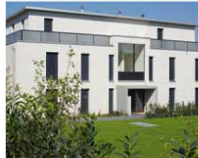
2) Eines von zwei Mehrfamilienhäusern mit Einstellhalle einer Wohnüberbauung in Langenthal BE von Karl Dill Bauführer/HE Hector Egger Bauunternehmungen AG, Langenthal
