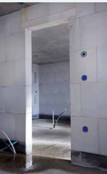
▲ Unversehrte KS-QUADRO E Wände mit intelligentem Innenleben.
