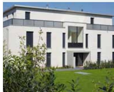
2) L'une de deux habitations collectives avec garage souterrain dans une zone résidentielle de Langenthal (BE), par Karl Dill chef de chantier/HE Hector Egger Bauunternehmungen AG, Langenthal
